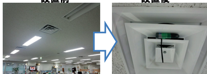
C:執務室天井 空調吹き出し口 設置前 設置後
